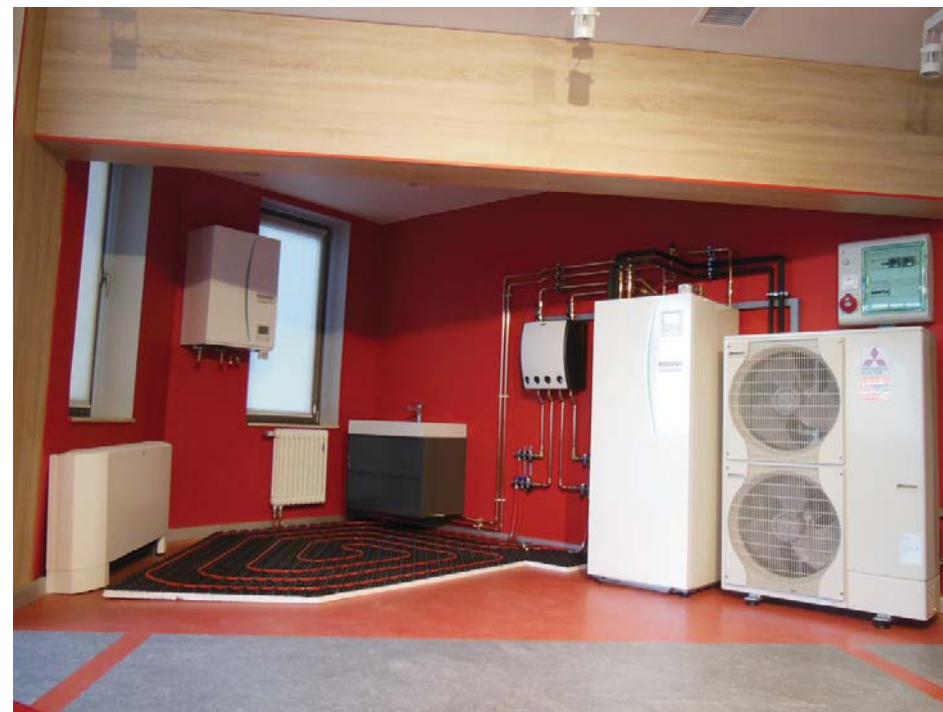
СИСТЕМА ОТОПЛЕНИЯ И ГВС «ECODAN» С ТЕПЛОВЫМ НАСОСОМ «ZUBADAN»
